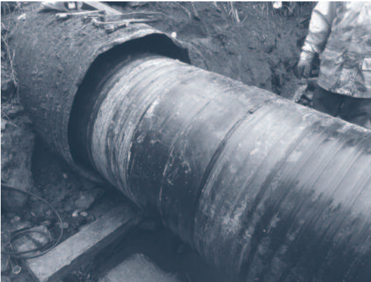
Revêtement intérieur posé durant les travaux de restauration, lac Cheam, 2013.
